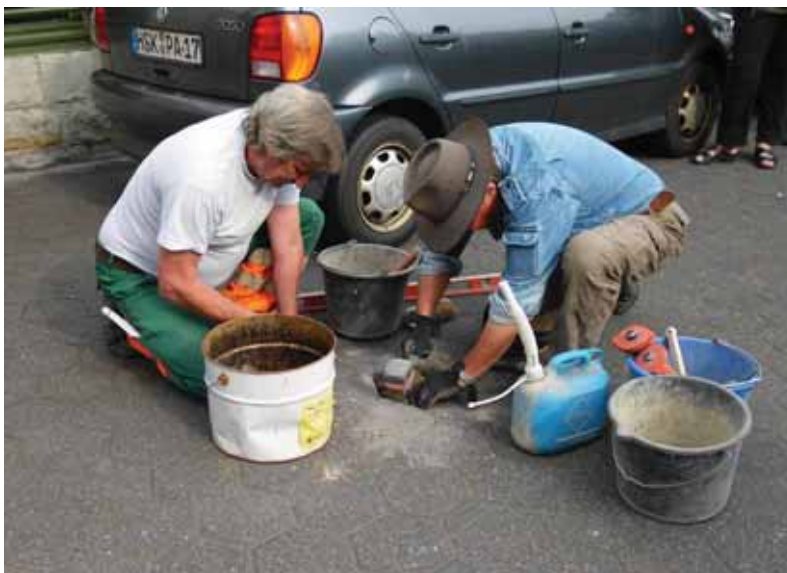
Gunter Demnig und Arnold Hengesbach, Mitarbeiter des Baubofs Meschede, vor dem Haus Kampstr. 1 bei den Vorbereitungen.
