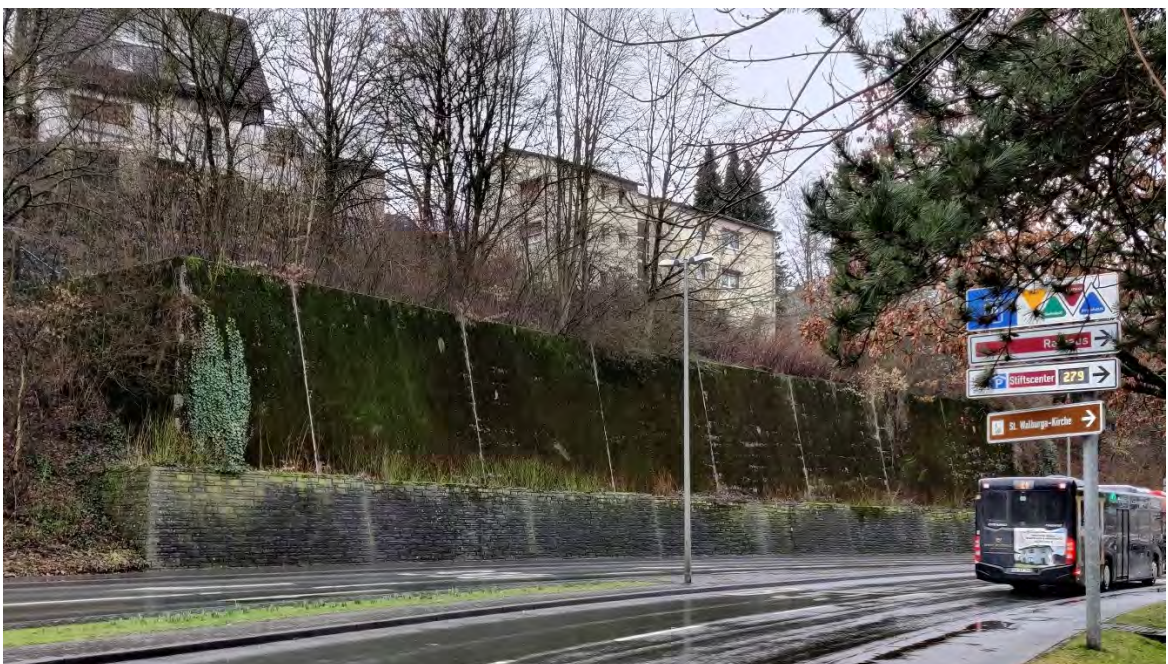
Abbildung 17: Stützwand an der B 55 (Auf der Wieme)
