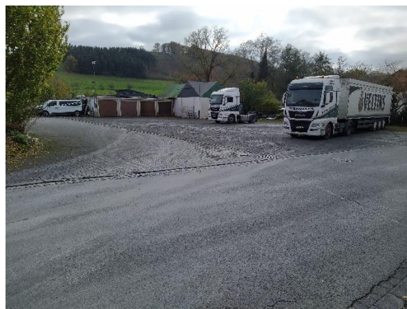
Abb. 7: Blick auf den Änderungsbereich 2 aus Richtung Norden (Eigene Aufnahme; Oktober 2024)
