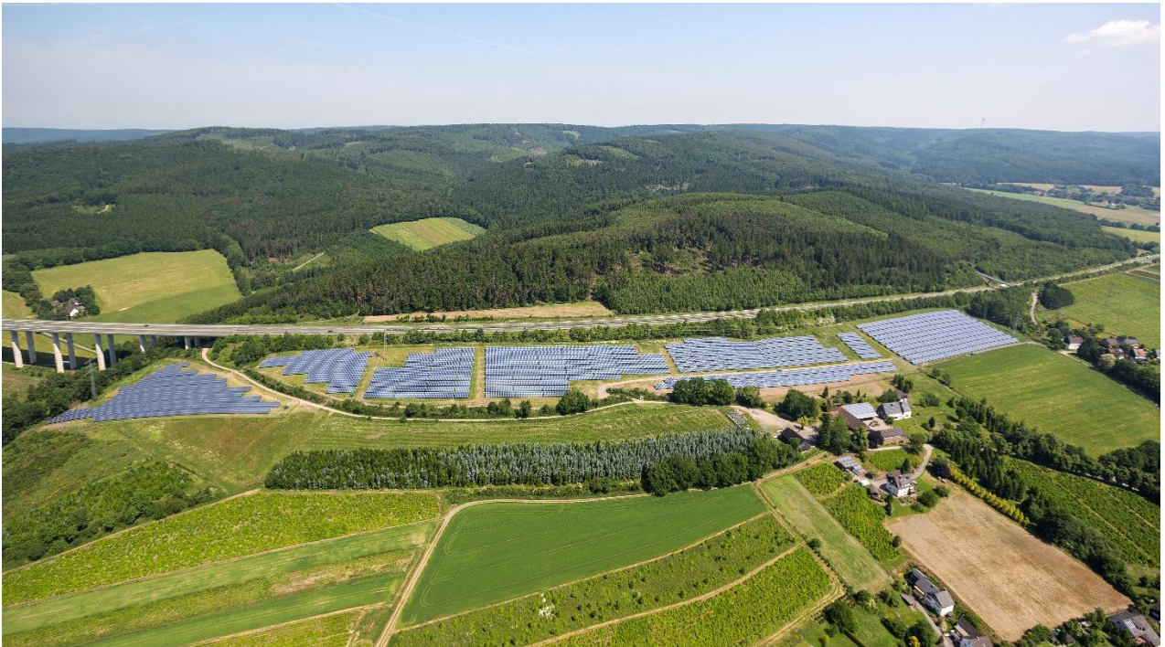
Abbildung 1: Photovoltaikfreiflächenanlage im privilegierten Raum entlang der BAB 46 bei Stockhausen
